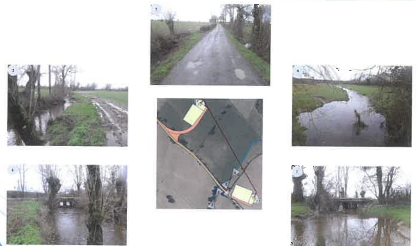
Figure 27 : Localisation et illustrations du ruisseau de la Mare aux Canes au niveau d'un ouvrage de franchissement sous une voirie renforcée pour l'accès à l'éolienne E4 (photos prises au cours de l'hiver 2019-2020 particulièrement pluvieux)
